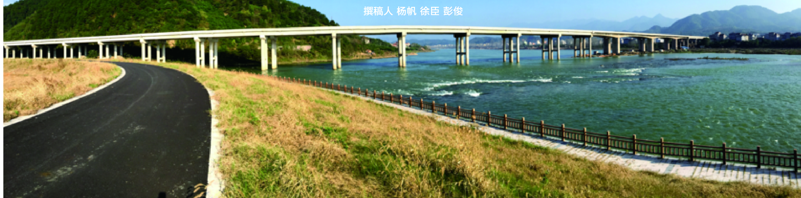
48省道延伸线青石特大桥
